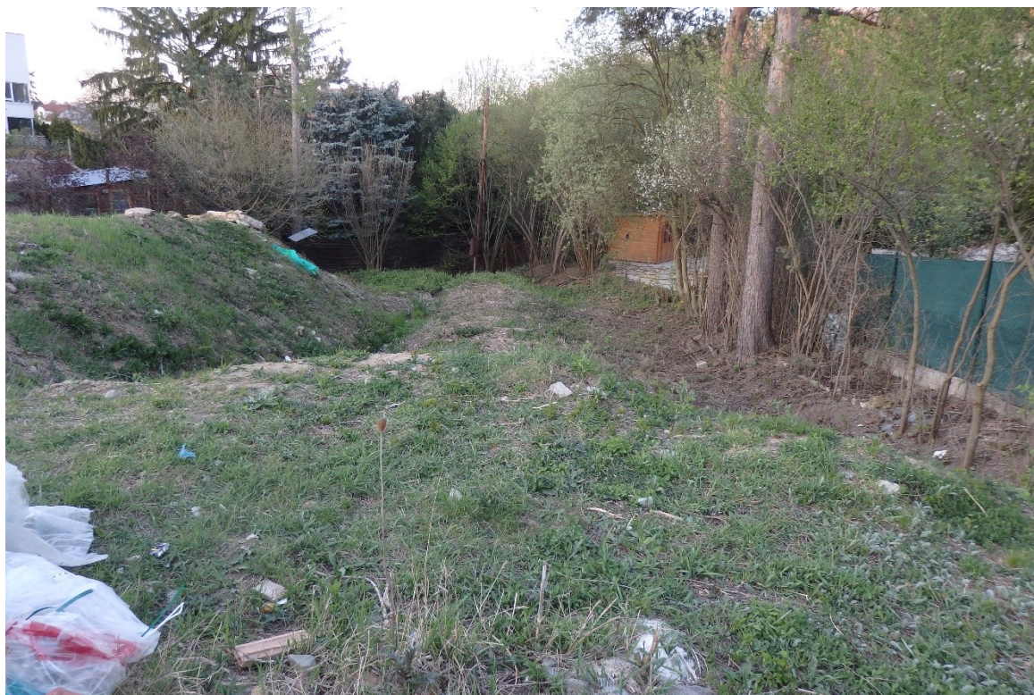
JV část lokality, odvodňovací travnatý příkop, převádějící srážkovou vodu do toku potoka
