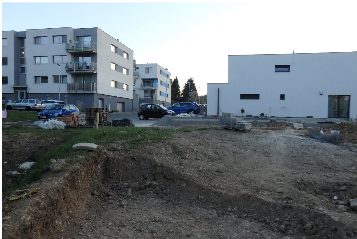
Horní část skládky zeminy, navazující na koncový úsek ul. Leknínové
