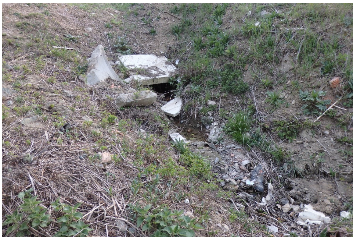
Stávající stav výtokového objektu dešťové kanalizace, začátek otevřené trasy k potoku
