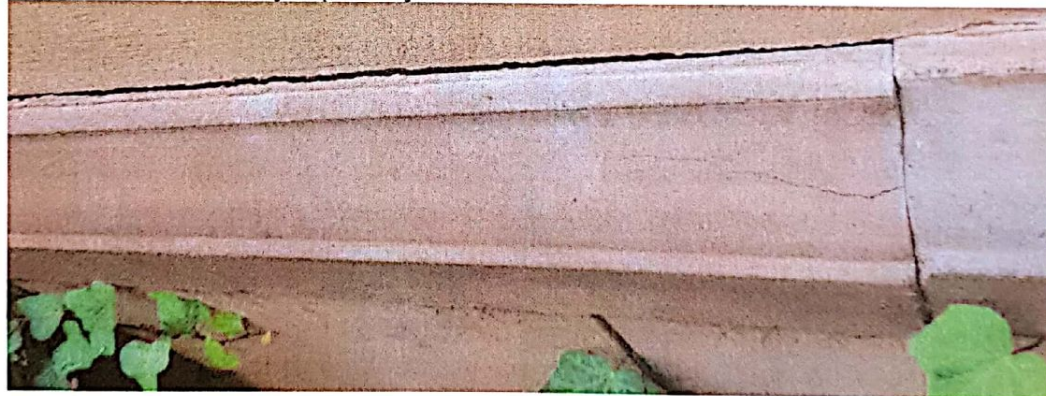
Foto č. 2 – uvolněný a prasklý obklad soklu
