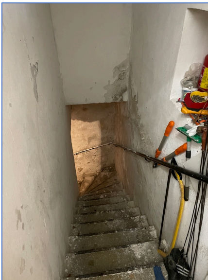
Prostor schodiště do sklepa před osekáním omítek
