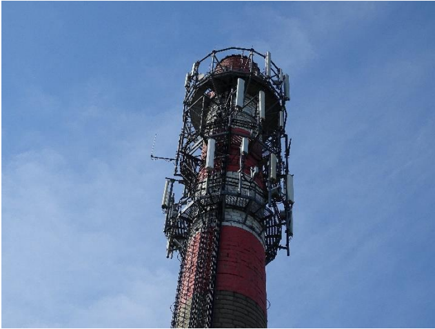
Obr. P3-5 – Detailní pohled na ochozy komínu (Terezy Novákové 62, Brno)
