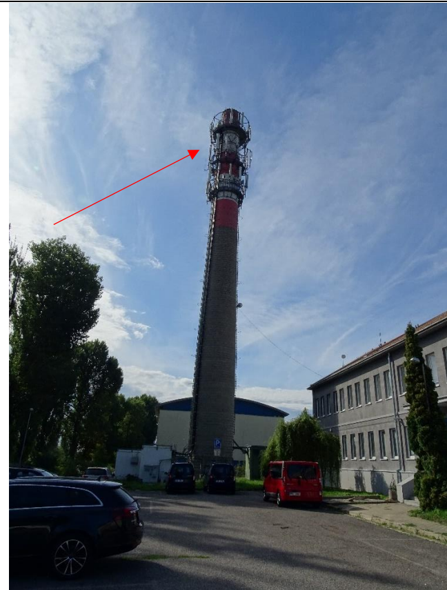
Obr. P3-1 – Komín celkový pohled. Anténa bude umístěna na prostředním ze tří ochozů. (Terezy Novákové 62, Brno)
