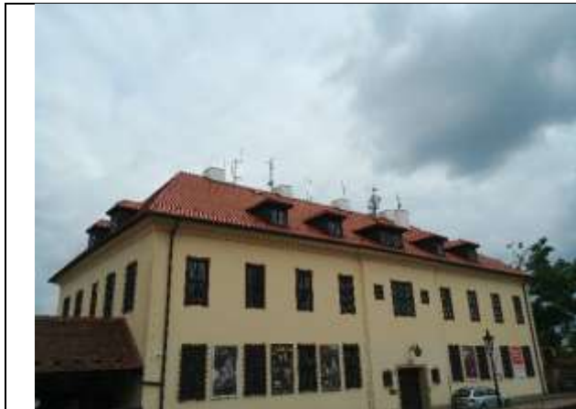
Obr. P1-1 – umístění převaděče vysílače v administrativní budově u jihovýchodního bastionu
