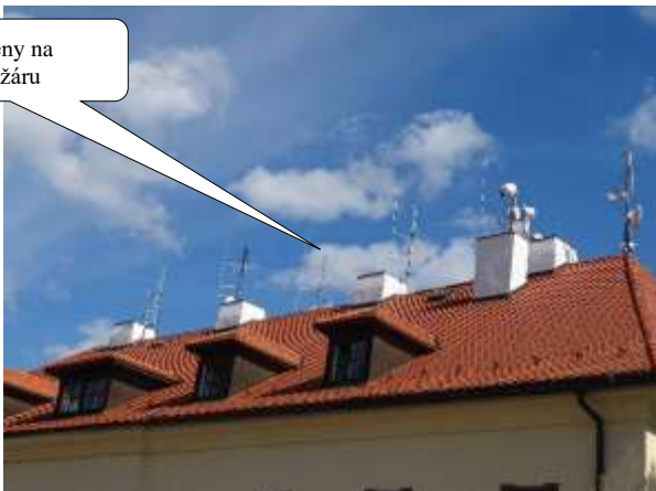
Obr. P1-3 – střecha administrativní budovy, umístění antény VIS na volném stožáru
