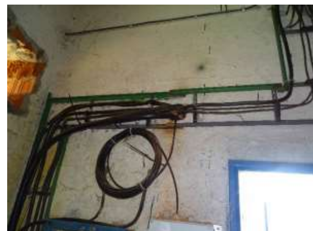
Obr. P2-12 – stávající průraz z budovy výměníku
