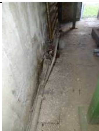
Obr. P2-14 – stávající trasa v kabelovém kanále budovy výměníku
