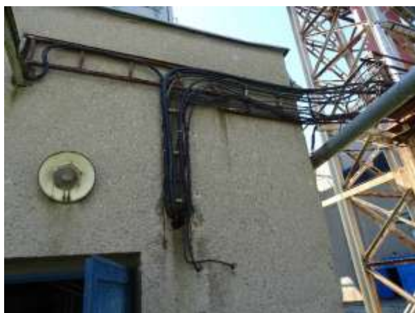
Obr. P2-11 – stávající průraz z budovy výměníku ke konstrukce závěsu 1 pro nový přívod napájení převaděče (kabel CYKY-J 3x2,5)
