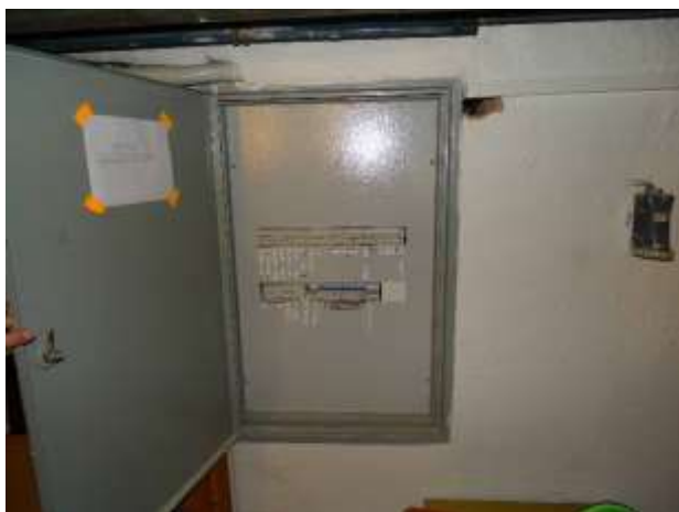
EST.1 – rozvaděč objektu bude doplněn jističem 1f/16A/B a podružným měřením
