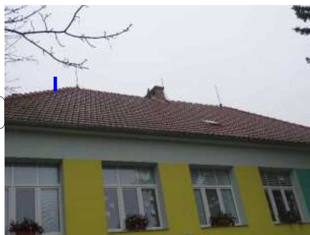
EST.1 – pozice stožáru sirény na střeše MŠ
