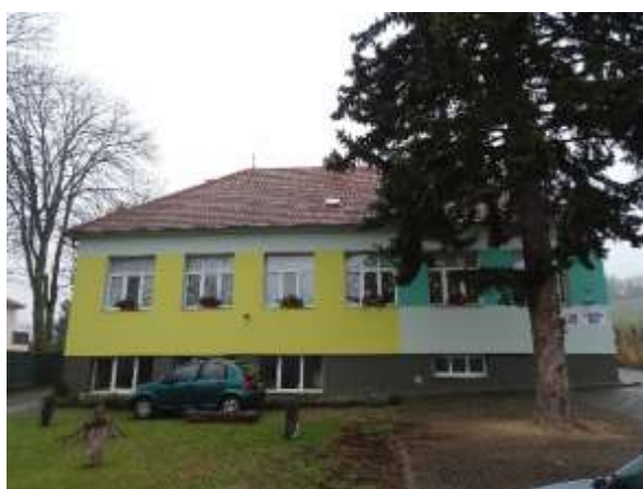
EST.1 – objekt MŠ vhodný k instalaci nové sirény
