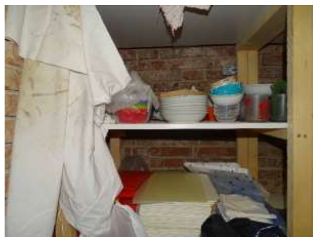
EST.1 – trasa přívodu OS sirény napájení – suterén (umístění nefunkčního komínu)
