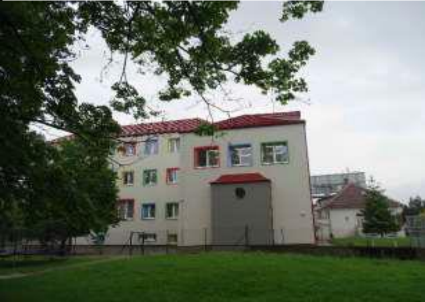
Obr. EST.9-1 - Objekt umístění sirény
