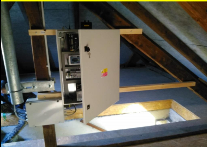
obr. EST.9-3 - Umístění řídicí jednotky sirény
