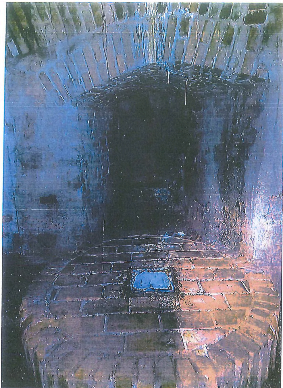
Revizní šachta kanalizace, jižní nika – střílna
