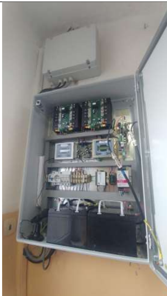
Obr. ESN.7-5 – otevřený rozvaděč sirény, zapojení
