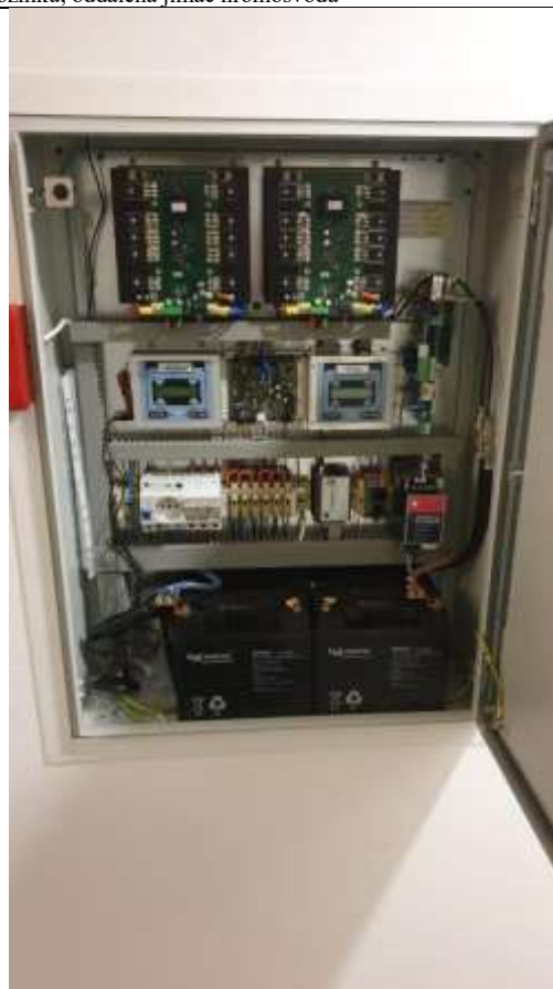
Obr. ES.25-4 – otevřený rozvaděče sirény
