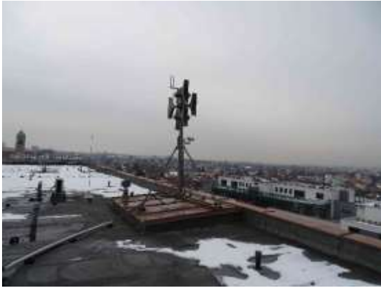
ES.25 – Původní elektronická siréna ES UEAJ na střeše ÚMČ Židenice
