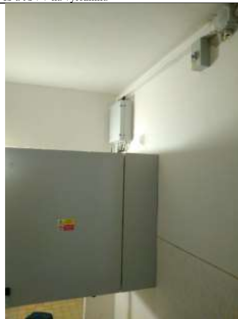
Obr. ES.21-4 – umístění rozvaděče sirény, krabice přepětových ochran a rozvodnice s jističem a měřením přívodu sirény, trasy
