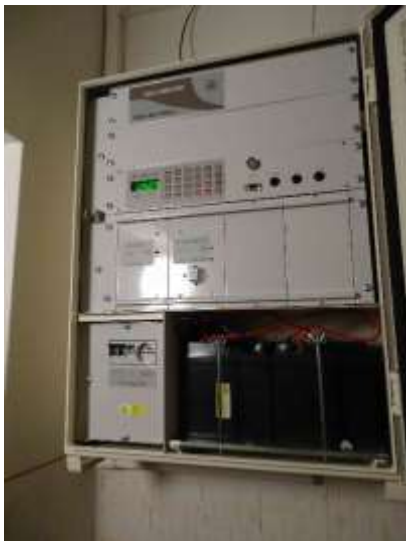
ES.21 – Původní elektronická siréna ES UEAJ
