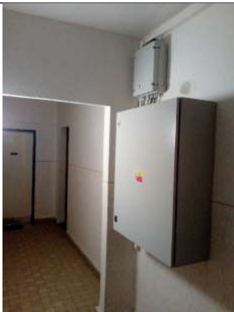
Obr. ES.21-3 – umístění rozvaděče sirény a krabice přepětových ochran
