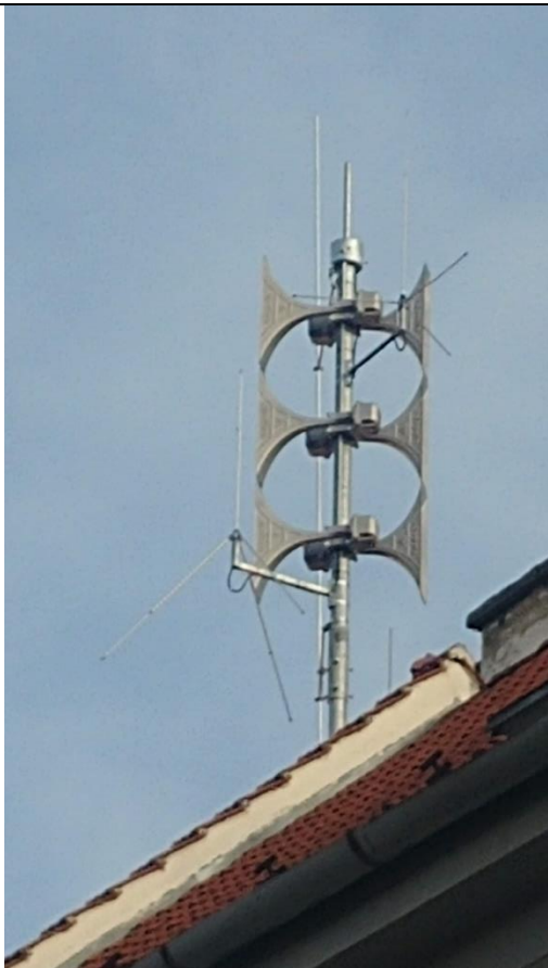
Obr. ES.24-3 – detail stožáru, 6 ozvučnic na novém stožáru
