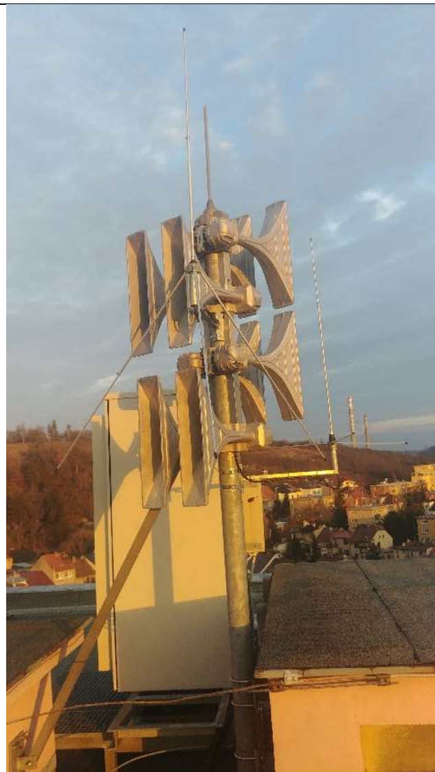
Obr. ES.21-2 – detail stožáru, 8 ozvučnic na původním stožáru, antény VIS a JSVV na výložníku
