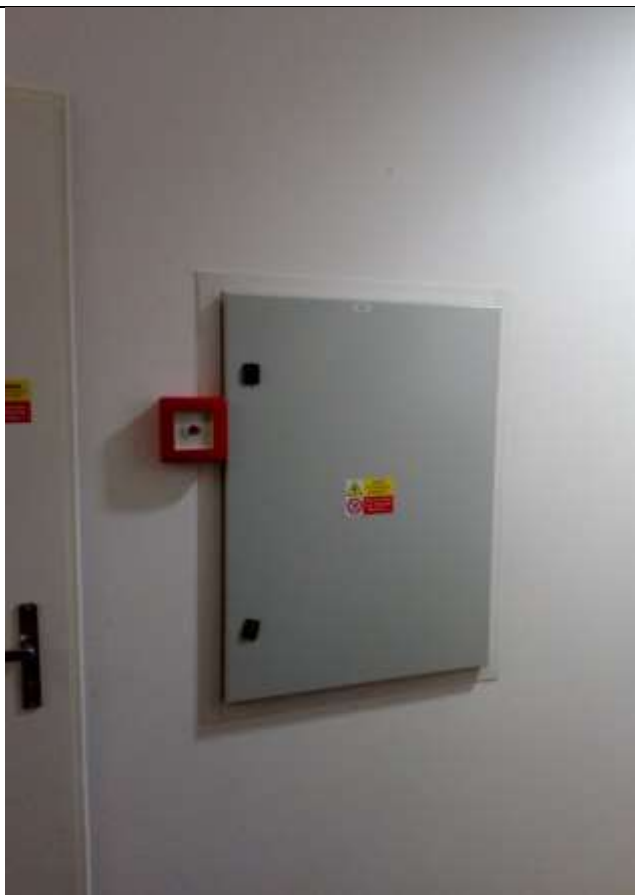
Obr. ES.25-3 – umístění rozvaděče nové elektronické sirény na chodbě 3.NP, nové tlačítko místního ovládání
