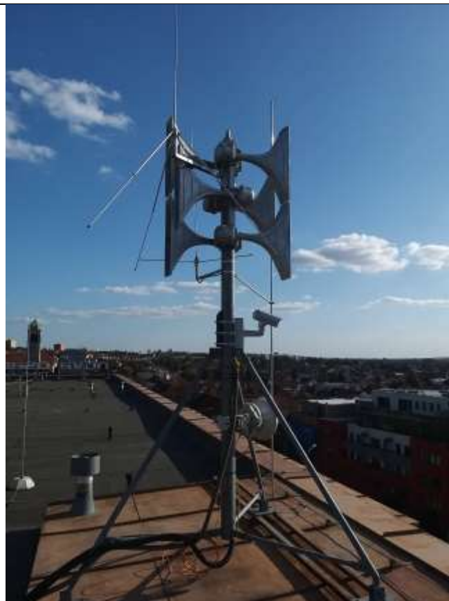
Obr. ES.25-2 – nová elektronická siréna eRotor 750 se 6 ozvučnicemi, anténami a oddáleným hromosvodem, antény VIS a JSVV na výložníku, oddálená jímač hromosvodu
