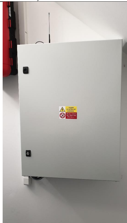
Obr. ESN.6-4 – umístění rozvaděče sirény
